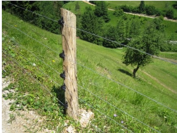
Slika 1: Lesen kol obodne ograje, na katerem so kakovostni in nepoškodovani plastični izolatorji
